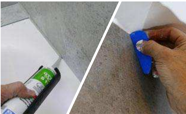
17. FUGEN MIT SILIKON ABDICHTEN UND SILIKON ABZIEHEN
