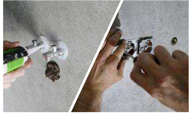
16. ÖFFNUNGEN MIT SILIKON AUSSPRITZEN UND ARMATUREN MONTIEREN
